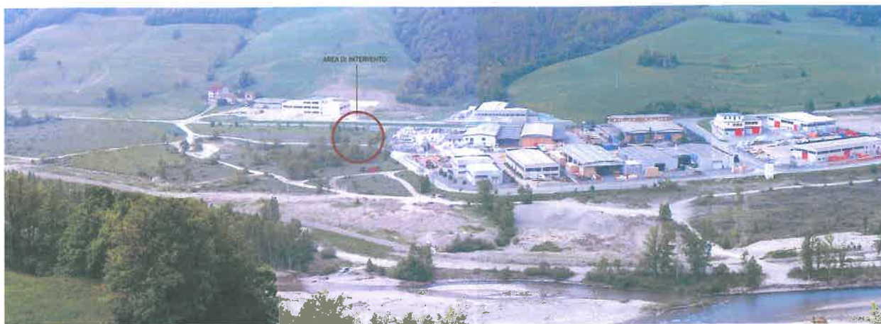
Vista panoramica dell'area industriale con localizzazione del punto di intervento
