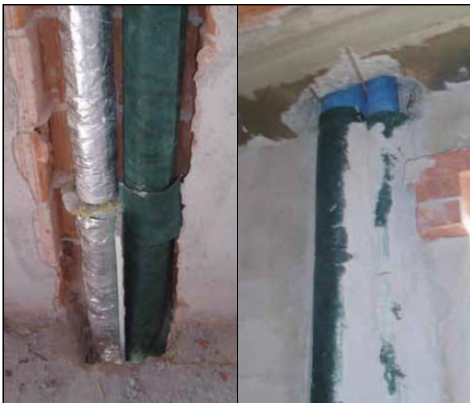
Figura 24: accorgimenti costruttivi (particolari isolamento acustico tubazioni, fonte indexspa.it )
