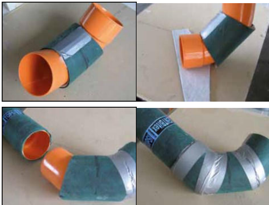
Figura 23: accorgimenti costruttivi (isolamento acustico curva tubazione di scarico, fonte indexspa.it )
