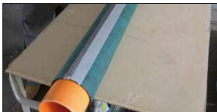
Figura 22: accorgimenti costruttivi (isolamento acustico di una tubazione di scarico, fonte indexspa.it )
