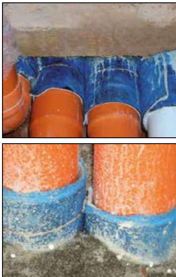
Figura 21: accorgimenti costruttivi (rivestimento impianti nel passaggio solai, fonte indexspa.it )
