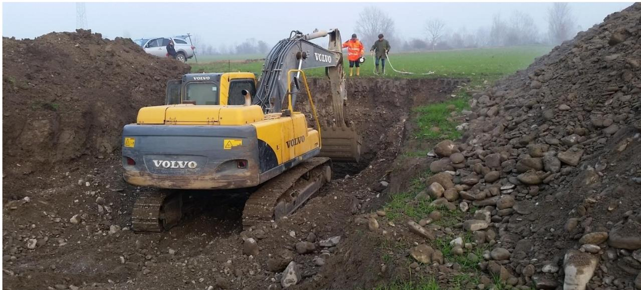
Figura C.22 Sulla destra in evidenza il cumulo in preparazione con angolo di riposo > 40°.
