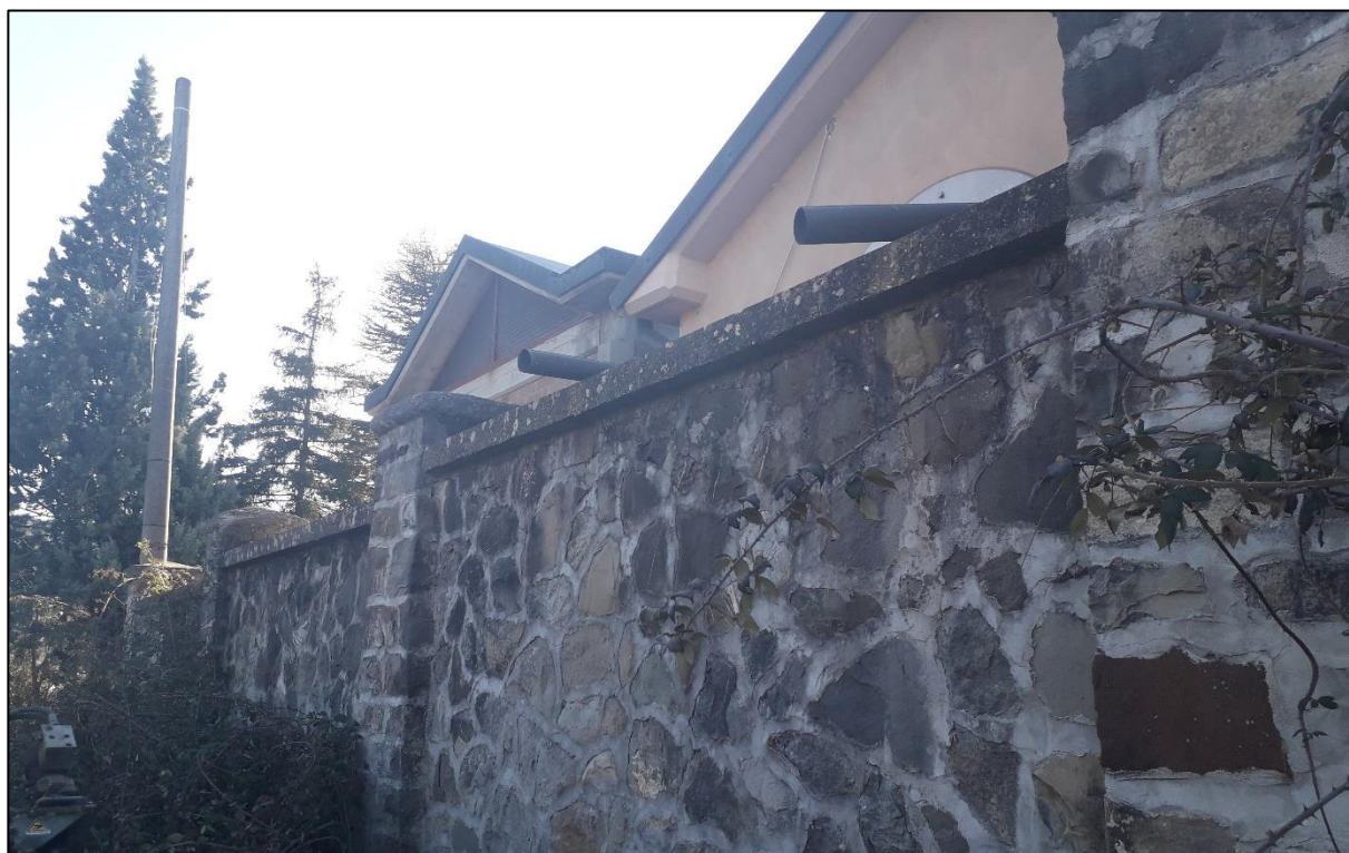
Fig. 3.3- Grondaie di scarico.
