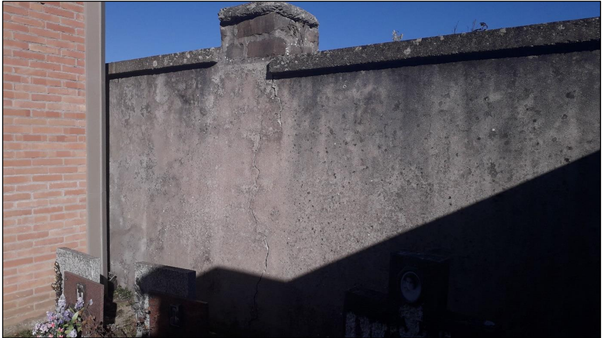
Fig. 3.1- Lesioni del muro perimetrale spigolo nord-est.
