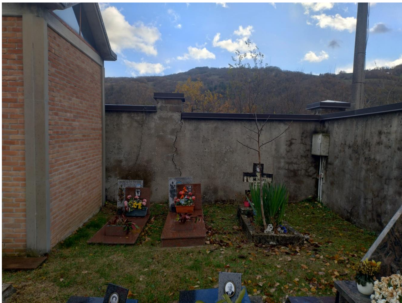
Figura 4 – Lesioni muro perimetrale
