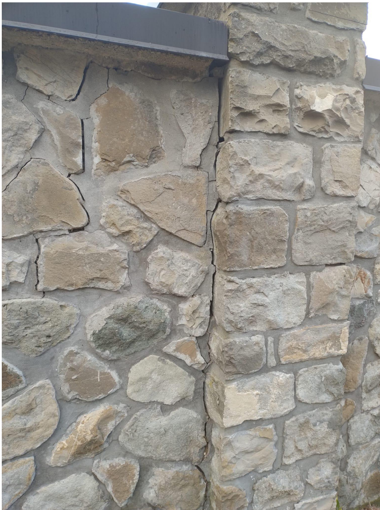
Figura 9 – Distacchi muro perimetrale in sasso
