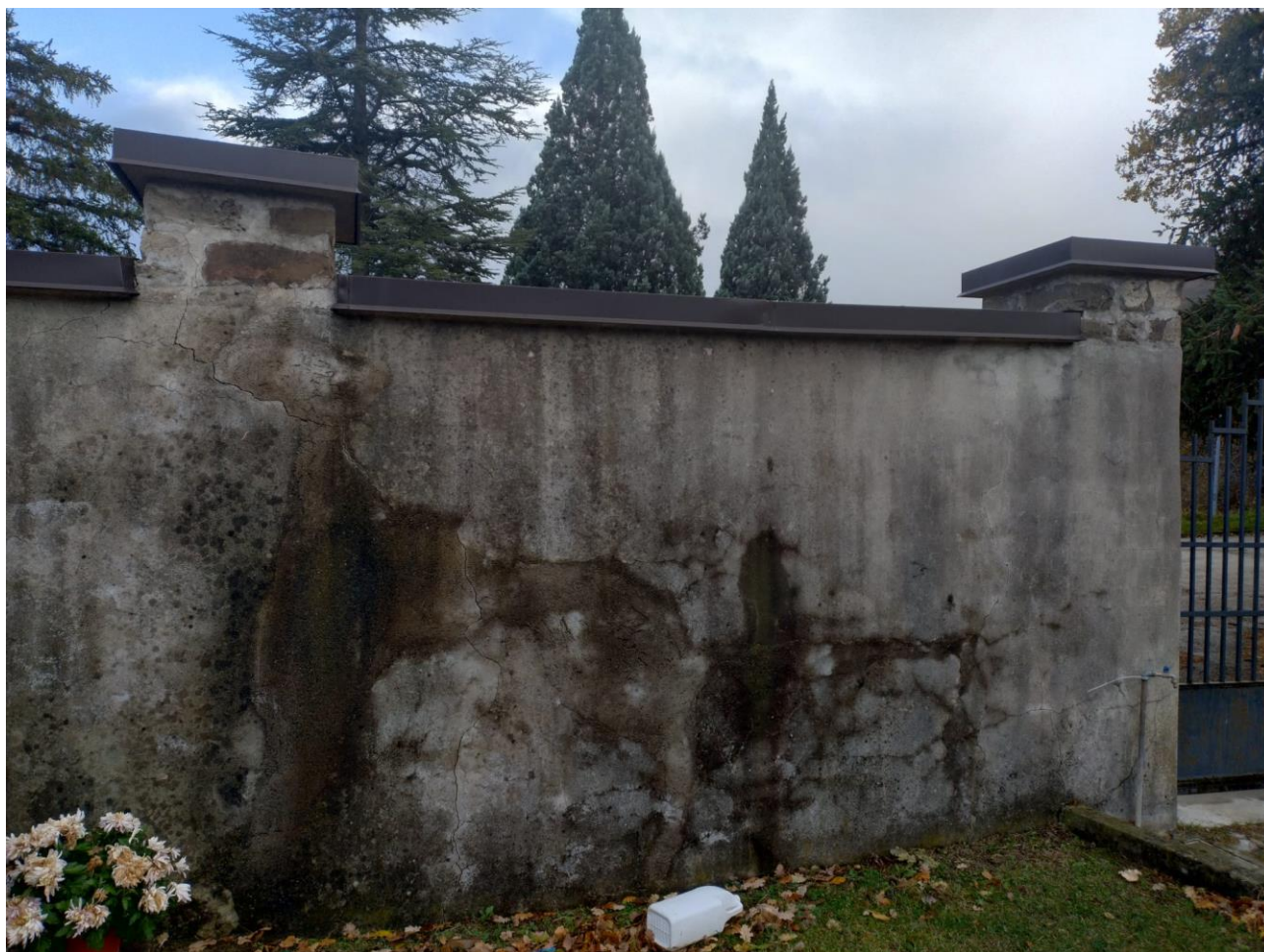
Figura 5 – Ammaloramento e lesioni muro perimetrale
