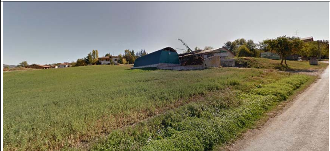
2) Vista dal lato ovest
